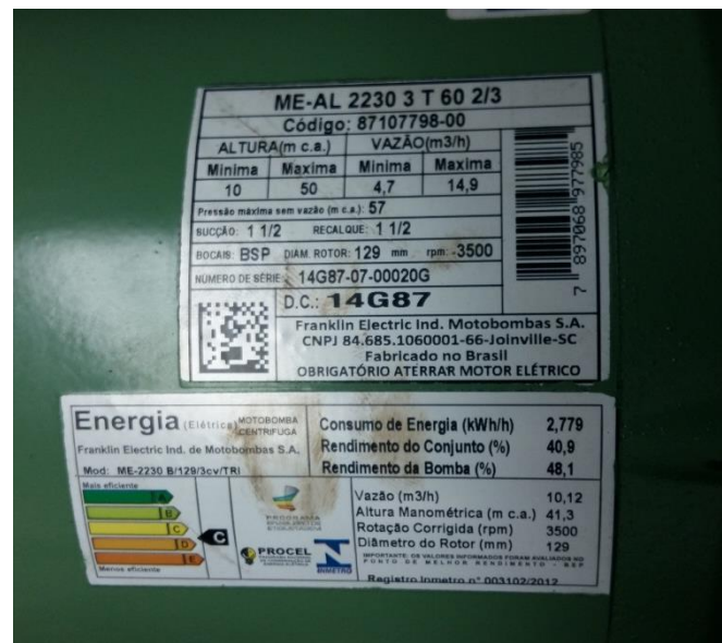
Figura 22 – Placa de Identificação da Bomba de Pressurização
