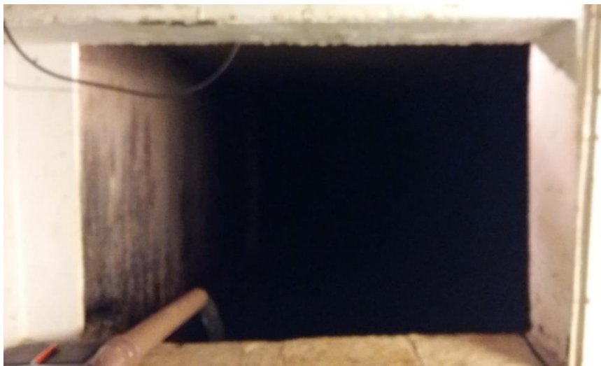
Figura 30 – Reservatório de Armazenamento de Água Isenta de Nitrato
