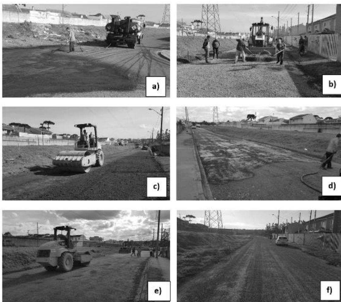
FONTE: O Autor (2017) (a) primeira pintura de ligação (b) aplicação de brita graduada reciclada de concreto (c) compactação da primeira camada (d) segunda pintura de ligação (e) compactação após aplicação de pó+pedrisco para capa selante (f) trecho concluído
