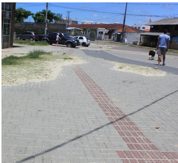
FIGURA 23: FAIXA DE PISO TÁTIL PARA DEFICIENTES VISUAIS
