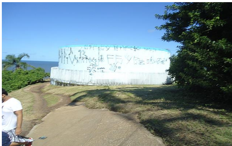
FIGURA 12: RESERVATÓRIO DESATIVADO DA SANEPAR LOCALIZADO NA PARTE SUPERIOR DO MORRO
