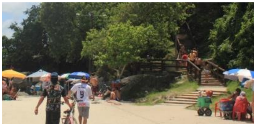
FIGURA 16: BASE DA ESCADARIA DE ACESSO AO ATRATIVO
