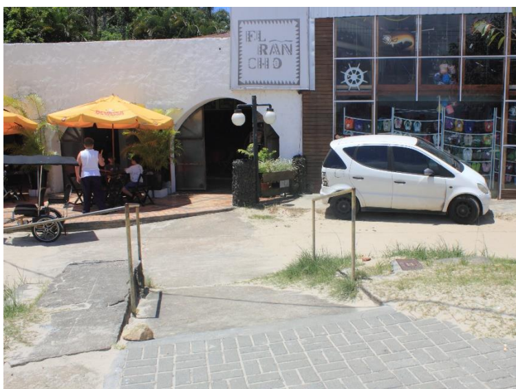
FIGURA 24: RAMPA DE ACESSO PARA CADEIRANTES
