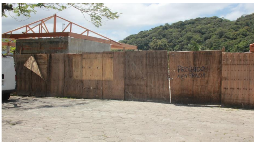
FIGURA 25: TRAPICHE EM REFORMAS
