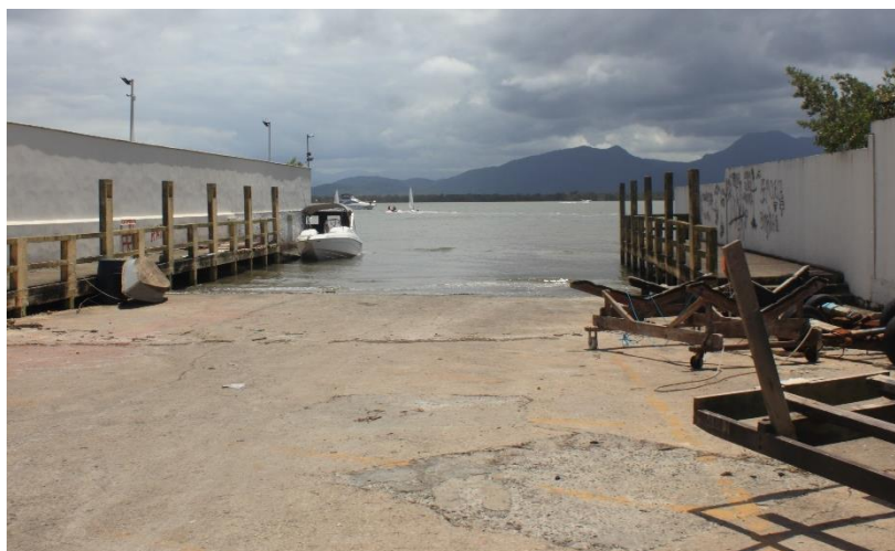
FIGURA 26: RAMPA E TRAPICHE DE ACESSO A BAÍA
