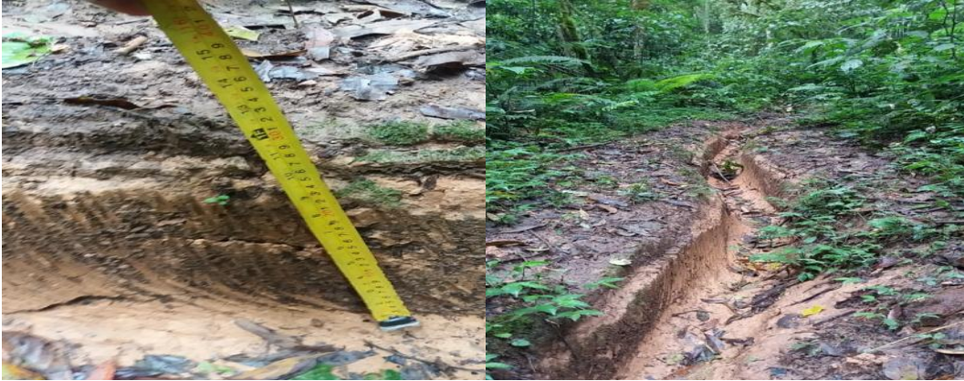
Fotos 2 e 3 - Profundidade do sulco
