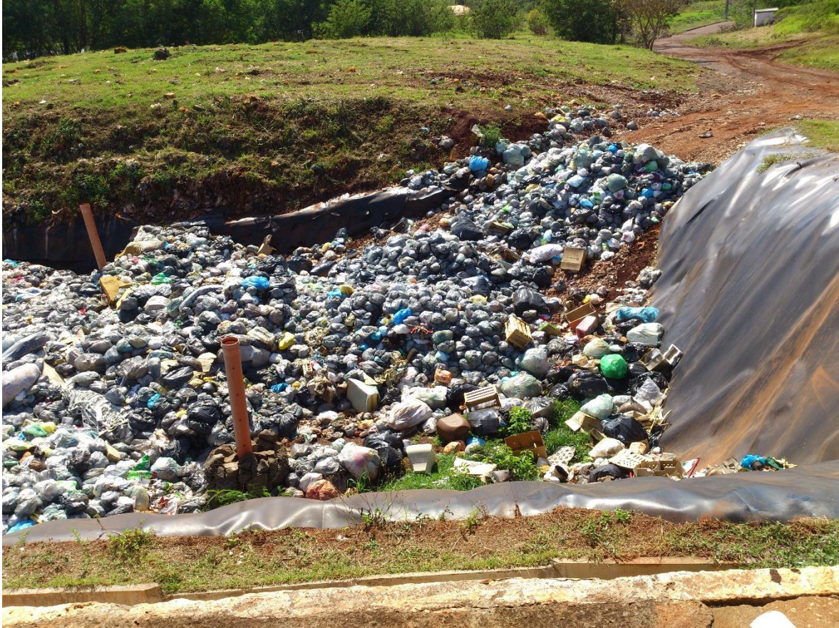
Figura 3: Vala de rejeitos – Aterro sanitário de Ibiporã. Fonte: O próprio autor, 2015.
