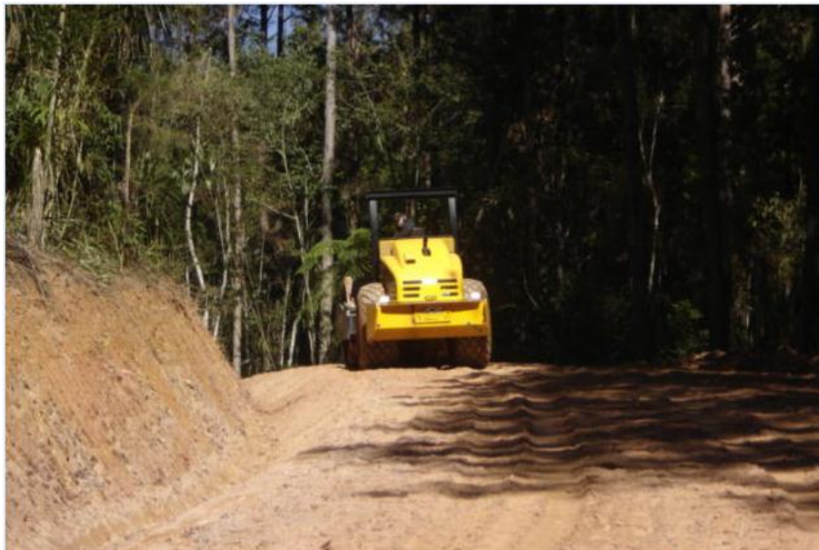
FIGURA 4 - ROLO COMPACTADOR FONTE: O Autor (2016)
