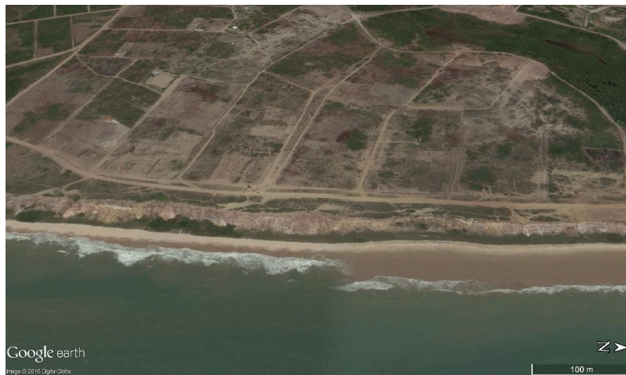
Figura 45. Uso inadequado do solo no topo da falésia na praia do Sol, João Pessoa – PB
