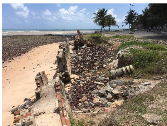
Figura 25. (a) e (b) Destrução da Praça de lemanjá causada pela ação das ondas na Praia do Cabo Branco, João Pessoa – PB
