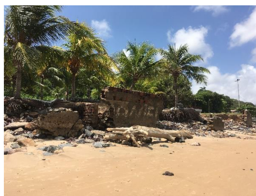
Figura 25. (a) e (b) Destrução da Praça de lemanjá causada pela ação das ondas na Praia do Cabo Branco, João Pessoa – PB
