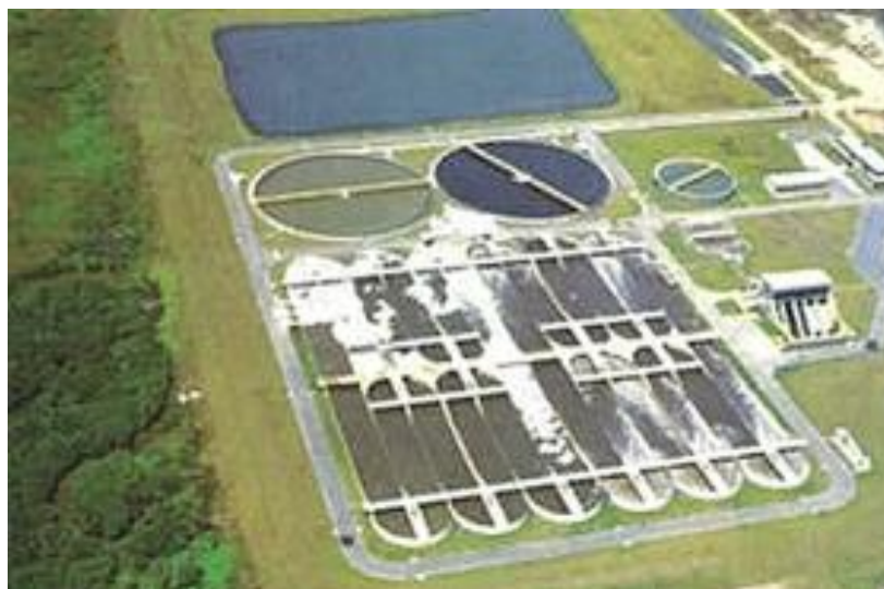
Figura 4: Estação de esgoto ETE Belém, Curitiba, Paraná. Vista panorâmica (Fonte: SANEPAR).
