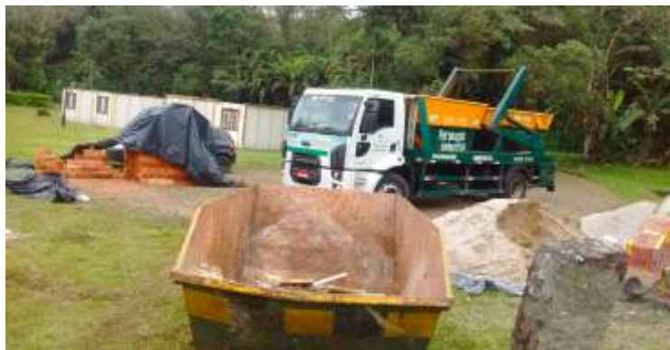
FIGURAS 20, 21, 22 e 23 - CAÇAMBAS DE OBRA
