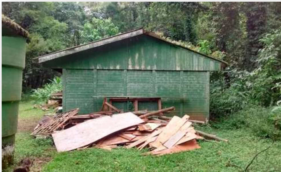
FIGURA 24 – CENTRAL DE RESÍDUOS
