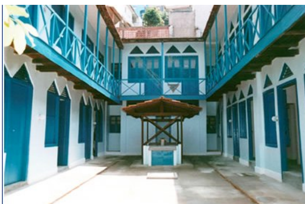
Figura 2: Vista pátio depois da reforma
