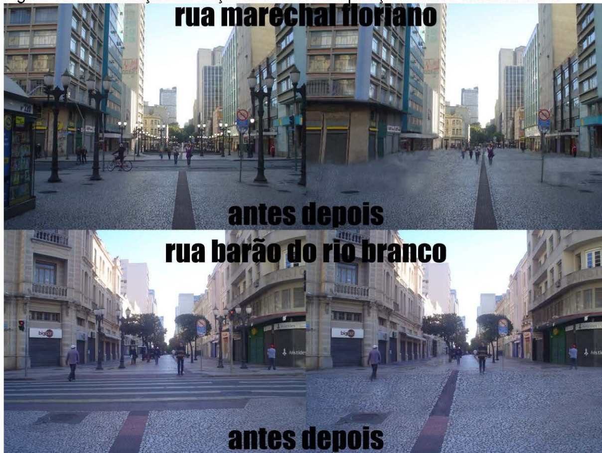
Figura 16: Continuação do calçamento nas transposições com o sistema viário
