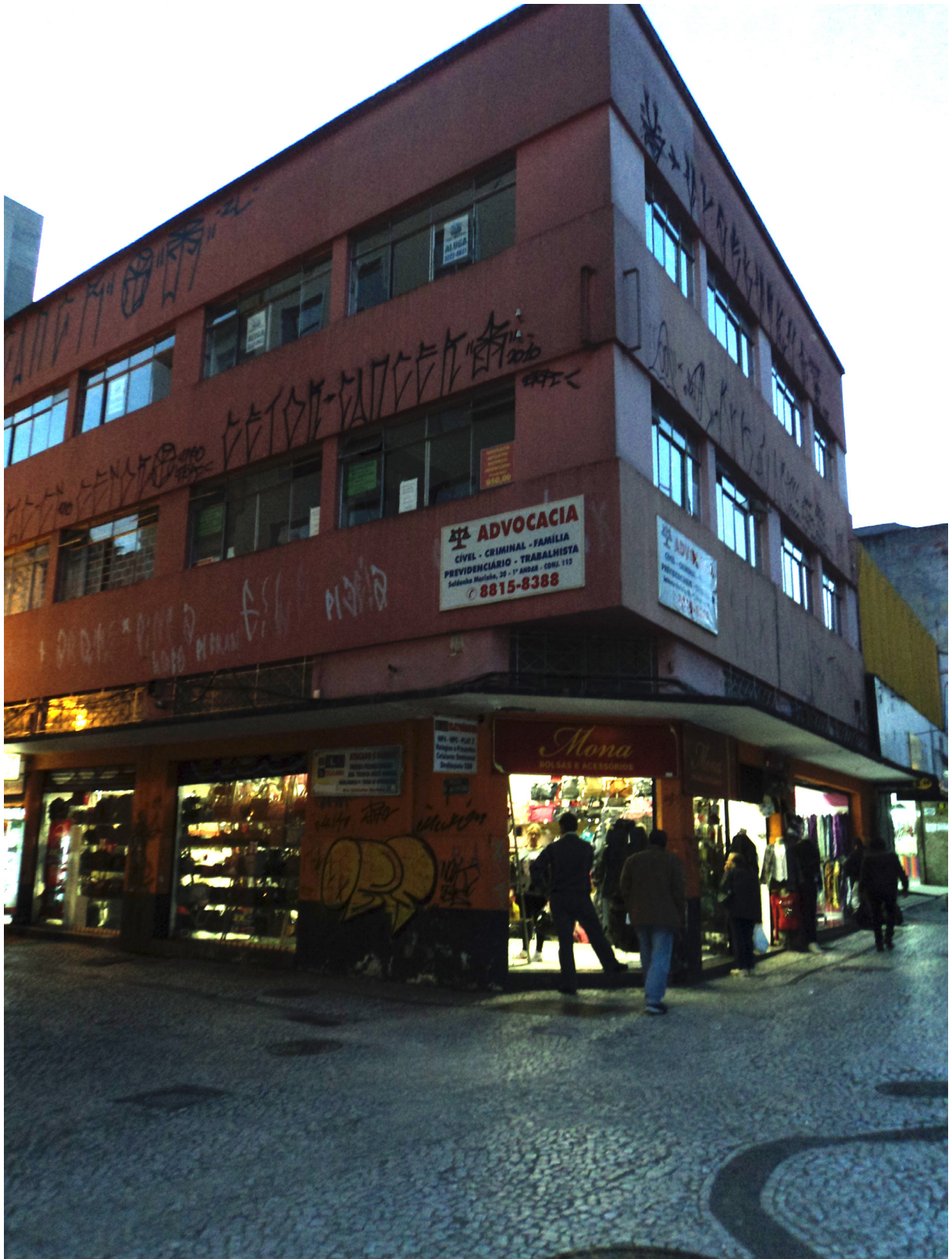
FIGURA 3 - PUBLICIDADE E VANDALISMO EM EDIFICAÇÃO DE ESQUINA NA RUA JOSÉ BONIFÁCIO, CURITIBA - PR
