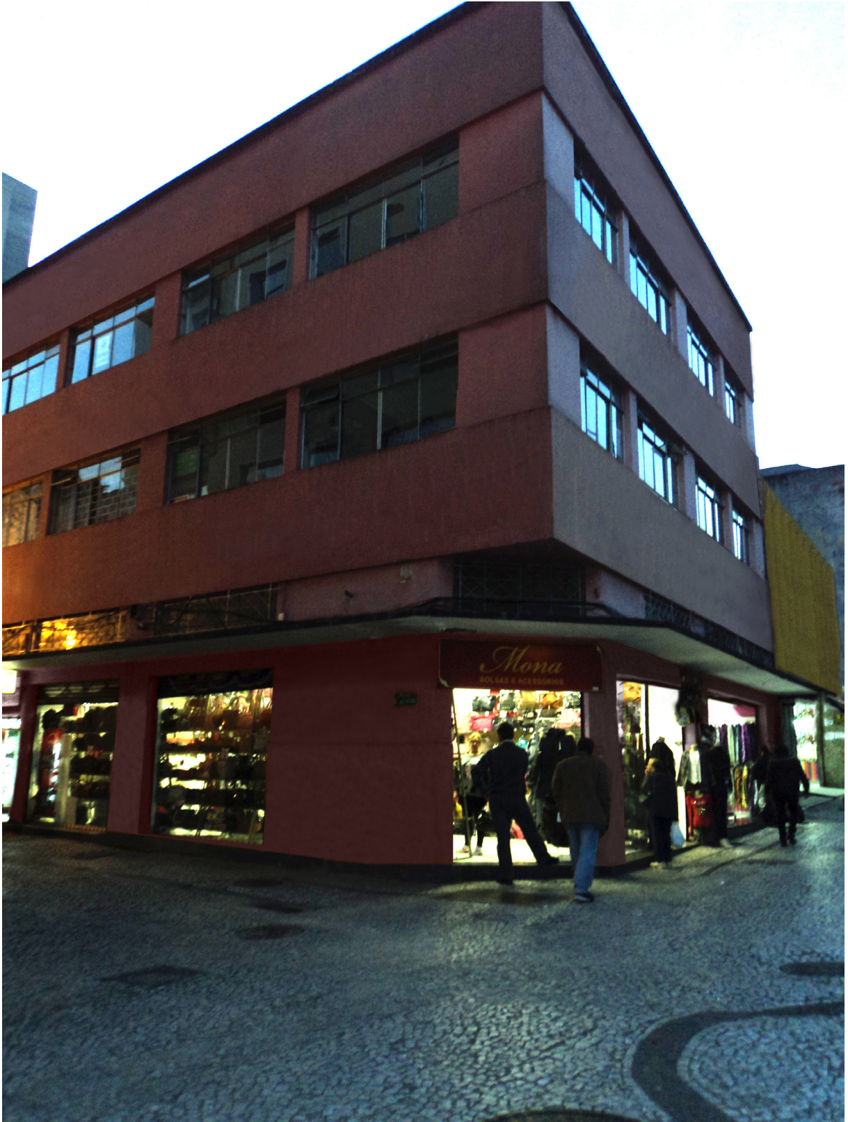
FIGURA 4 - ENSAIO INICIAL PARA DESPOLUIÇÃO DA FACHADA FONTE: A autora (2011)
