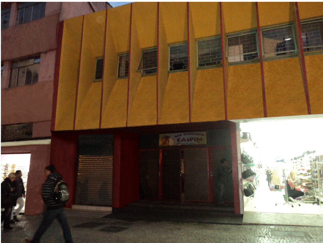
FIGURA 10 - ENSAIO INICIAL PARA DESPOLUIÇÃO DA FACHADA
