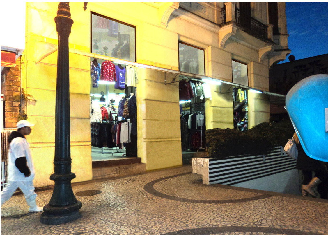
FIGURA 6 - ENSAIO INICIAL PARA DESPOLUIÇÃO DA FACHADA FONTE: A autora (2011)
