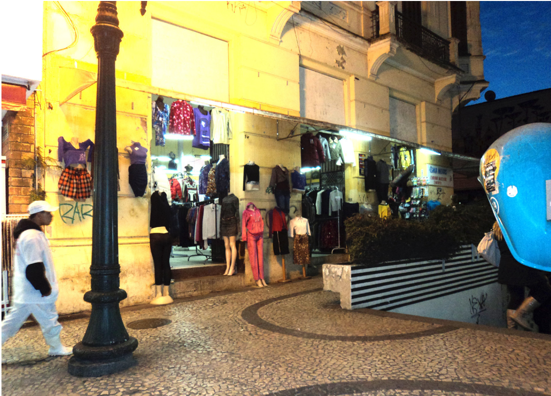
FIGURA 5 - FACHADA MAL CONSERVADA, PICHADA E OBSTRUÍDA POR PRODUTOS FONTE: A autora (2011)
