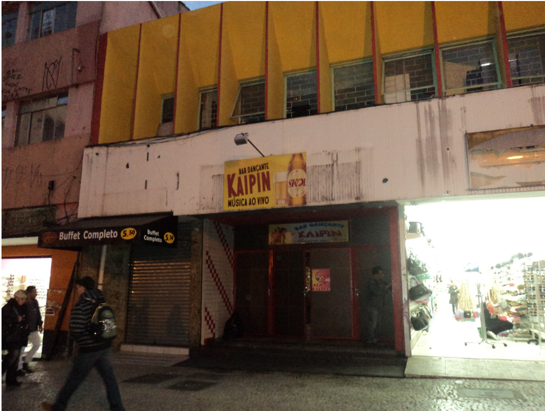
FIGURA 9 - FACHADA OCULTA POR ADIÇÕES
