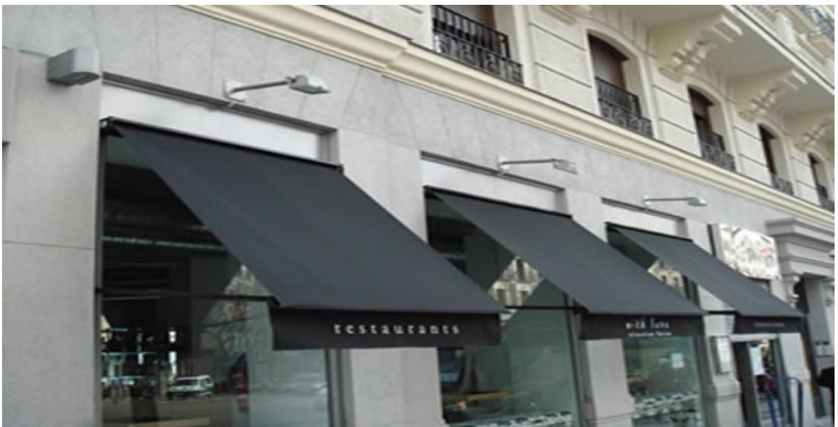
FIGURA 8 - EXEMPLO DE TOLDOS EM BOM ESTADO DE CONSERVAÇÃO E EM HARMONIA COM FACHADA COMERCIAL DE EDIFICAÇÃO ANTIGA FONTE: Toldos Design (2012)
