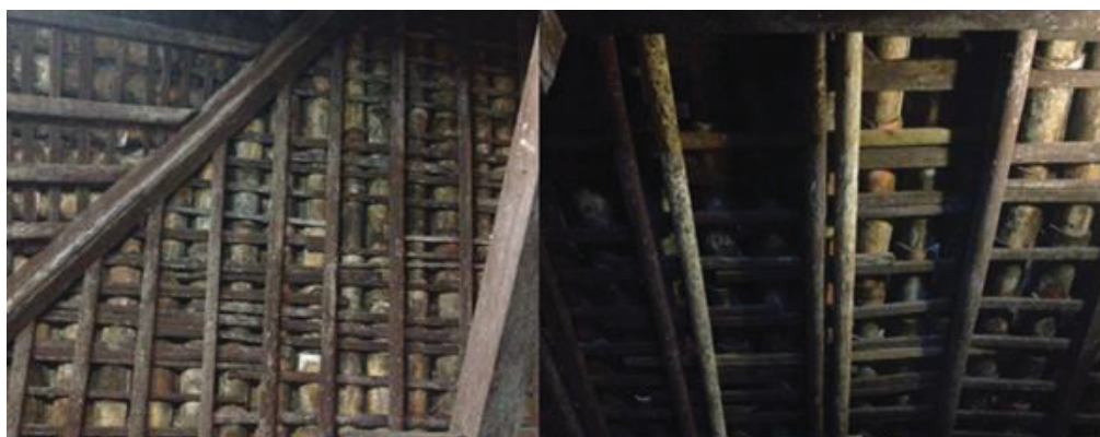
FIGURA 7 – TELHADO DO ENGENHO GNATA MUNICÍPIO DE MORRETES, CONSTRUIDO EM 1891, COM RIPAS E CAULES DA PALMEIRA JUÇARA
