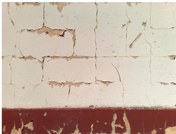
Figura 28 - Áreas externas sujeitas a sol forte, chuvas e variações bruscas de temperaturas.
