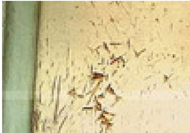
Figura 10 – Trincas e má aderência sobre madeiras, exemplo de defeito na pintura
