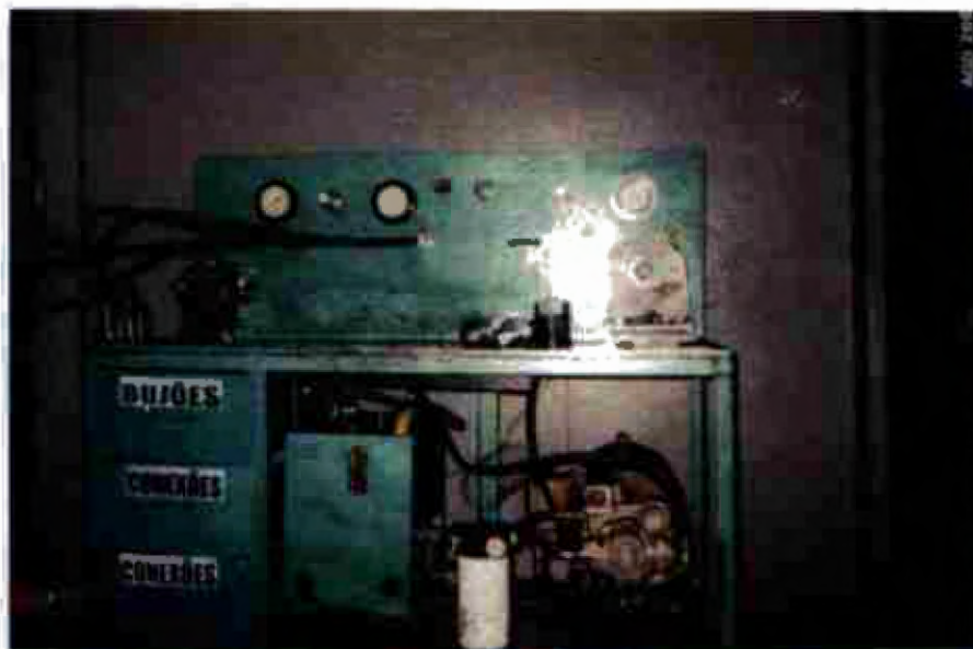
FOTOGRAFIA 5 – SETOR DE SERVIÇOS – MONTAGEM DE BOMBAS
