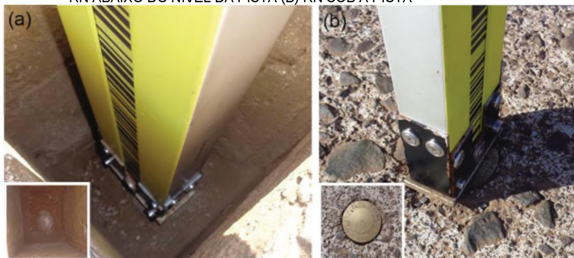
FIGURA 61 - REFERÊNCIAS DE NÍVEL LOCALIZADAS NA CRISTA DA BARRAGEM DA UHGJR (A) RN ABAIXO DO NÍVEL DA PISTA (B) RN SOB A PISTA
