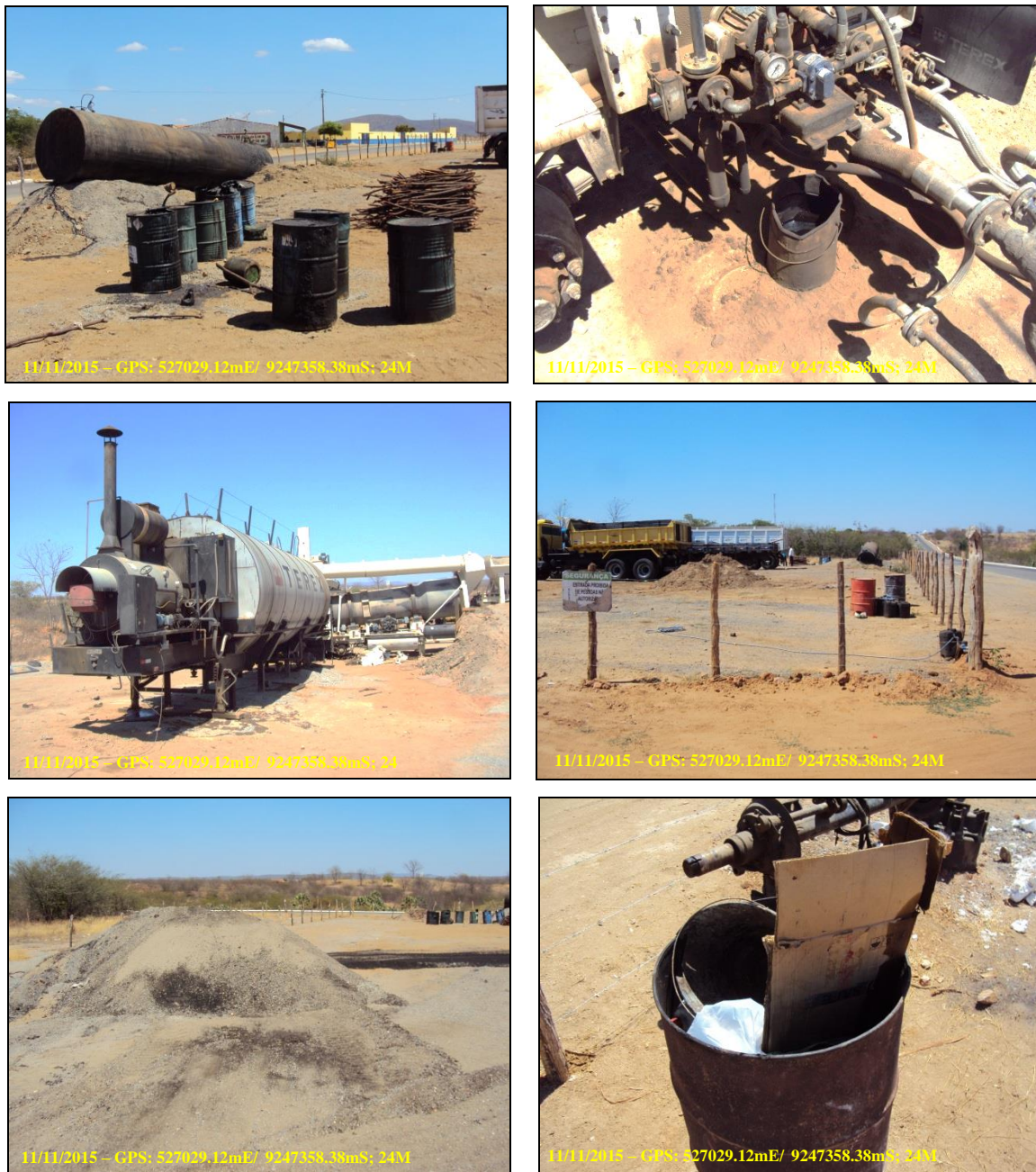
FIGURA 8 – ATIVIDADES INSPECIONADAS NO CANTEIRO DE OBRAS DA EMPRESA RESPONSÁVEL.
