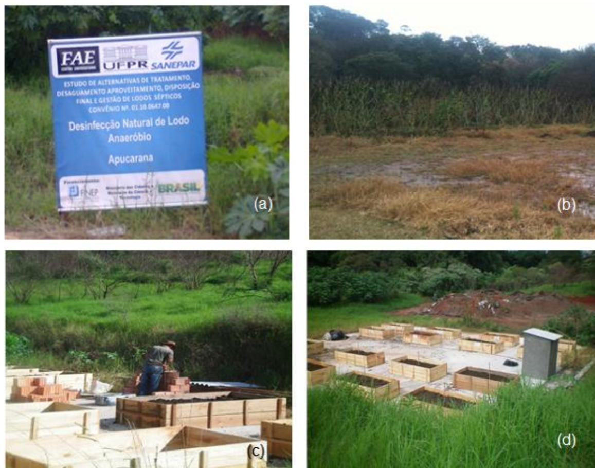
FIGURA 3.9 – CONSTRUÇÃO E MONTAGEM DO PÁTIO DESCOBERTO EM APUCARANA; A) IDENTIFICAÇÃO DO EXPERIMENTO; (B) ÁREA ONDE FOI CONSTRUÍDO O PÁTIO DE CIMENTO (C) UNIDADES EXPERIMENTAIS JÁ MONTADAS EM PÁTIO DESCOBERTO; (D) VISTA DO PÁTIO DESCOBERTO APÓS A MONTAGEM
