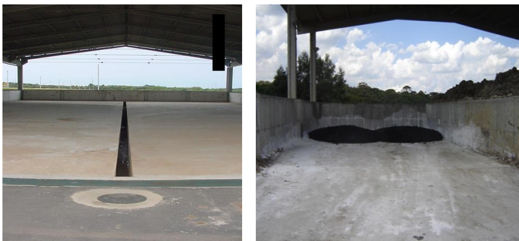
FIGURA 2.13 – PÁTIOS COBERTOS PARA ARMAZENAGEM DO LODO ALCALINIZADO EM ETE DA SANEPAR Fonte: O autor
