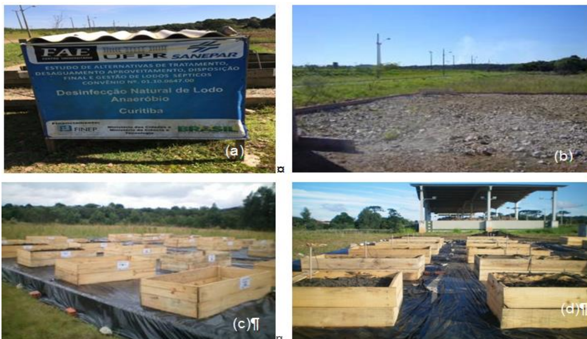
FIGURA 3.8 – CONSTRUÇÃO E MONTAGEM DO PÁTIO DESCOBERTO EM FAZENDA RIO GRANDE A) IDENTIFICAÇÃO DO EXPERIMENTO; (B) ÁREA ONDE FOI CONSTRUÍDO O PÁTIO DE CIMENTO (C) UNIDADES EXPERIMENTAIS JÁ MONTADAS EM PÁTIO DESCOBERTO; (D) VISTA DO PÁTIO DESCOBERTO APÓS A MONTAGEM COM O PÁTIO COBERTO AO FUNDO
