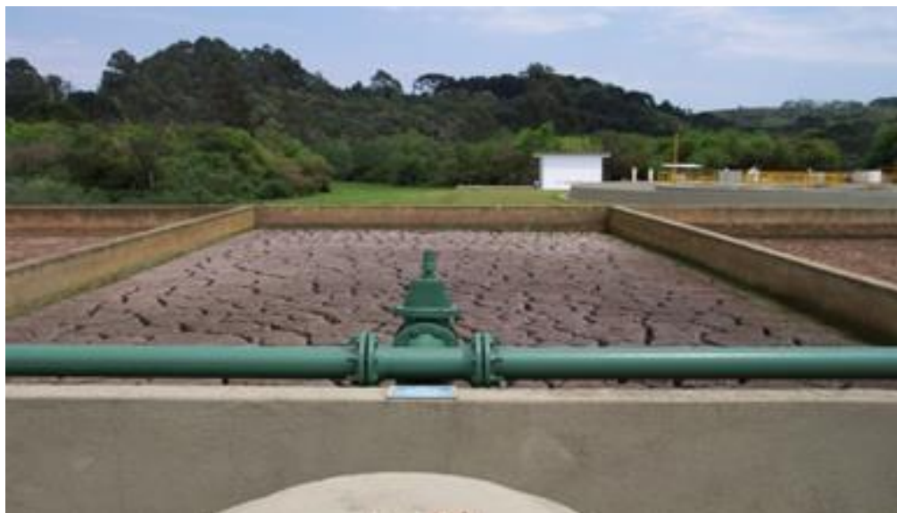
FIGURA 2.8 – VISTA GERAL DE LEITO DE SECAGEM CONVENCIONAL FONTE: O autor (2013)
