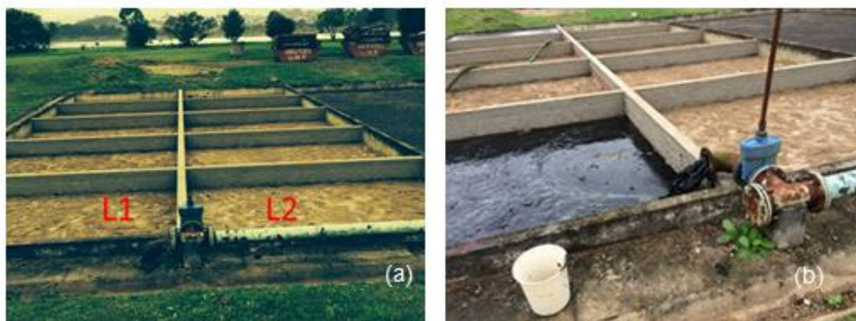
FIGURA 3.14 – LEITOS DE SECAGEM: (A) SUBDIVISÃO DO LEITO DE SECAGEM – LEITOS L1 E L2 (B) – ENCHIMENTO DO LEITO L1 ATRAVÉS DE TUBULAÇÃO DA ETE Fonte: O autor (2014)
