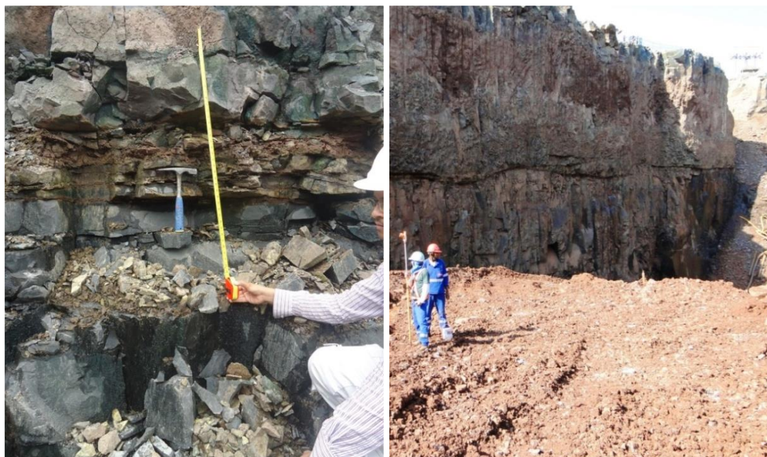
FIGURA 25 – Imagens da junta-falha durante as escavações
