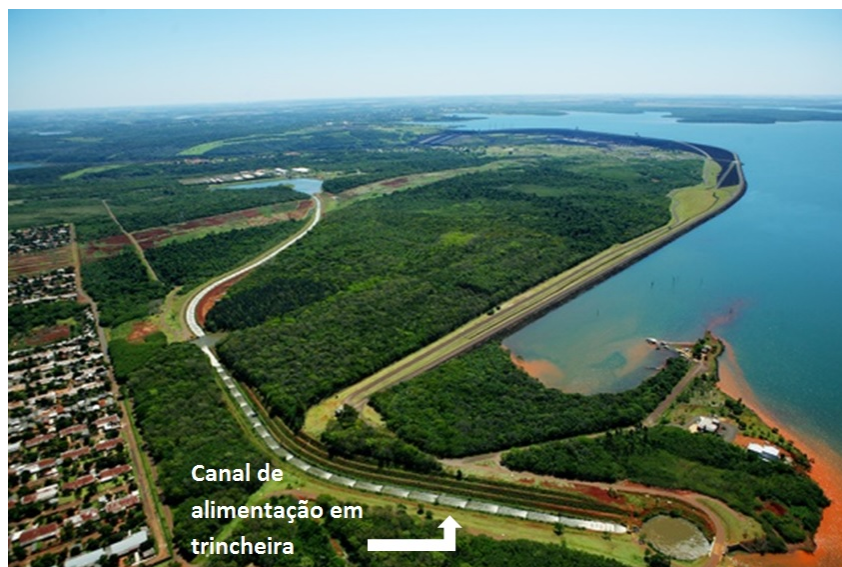
Figura 1 – Vista panorâmica do canal de alimentação em trincheira Fonte: http://jie.itaipu.gov.br/ (acesso em 18/05/2017).
