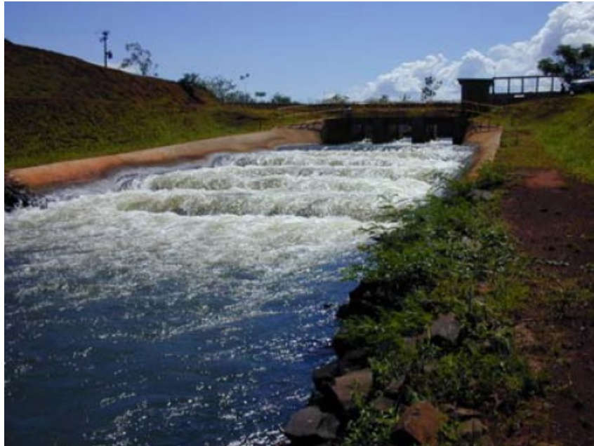
Figura 39 – Trecho do canal de alimentação em trincheira no parque da Usina Hidrelétrica de Itaipu.
