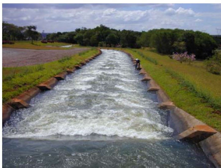
Figura 30 – Trecho do canal de iniciação no parque da Usina Hidrelétrica de Itaipu Fonte: Friedrich et al. (2007).
