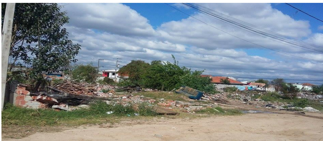
FOTO 04 – CASAS DEMOLIDAS DA VILA UNIÃO EM PINHAIS
