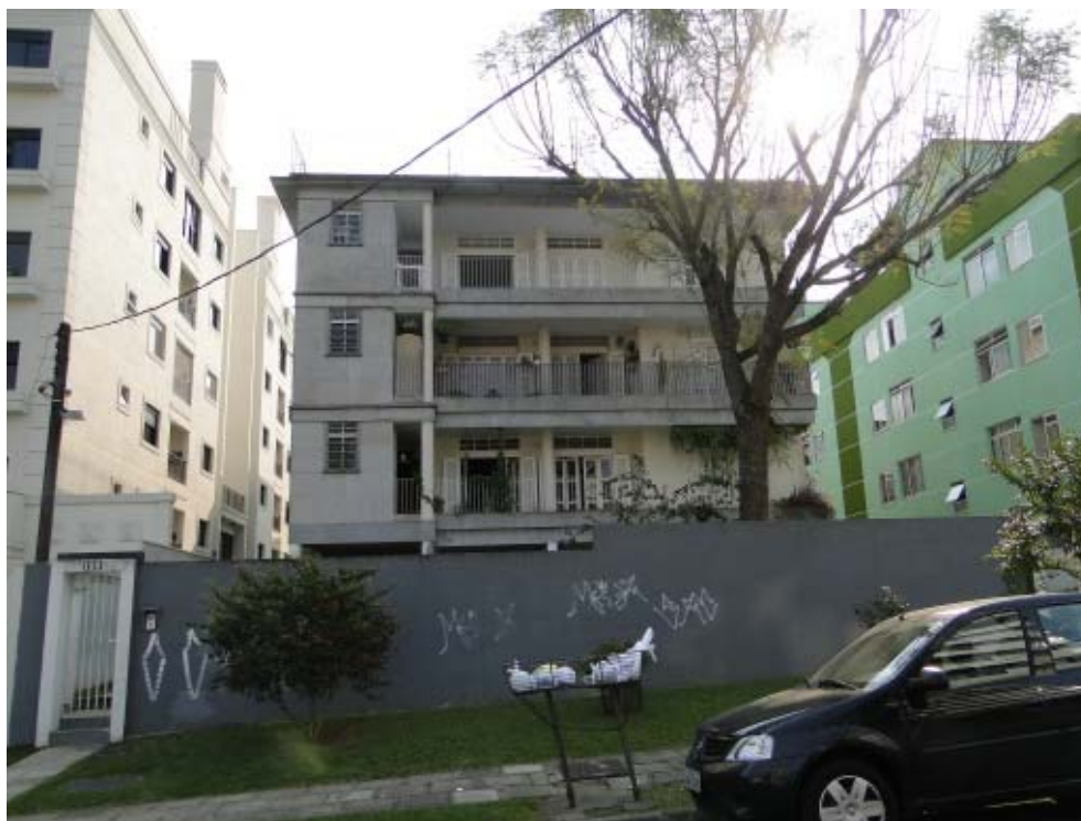
Figura 18: Fachada da edificação com telhado verde. Fonte: A autora (2011).
