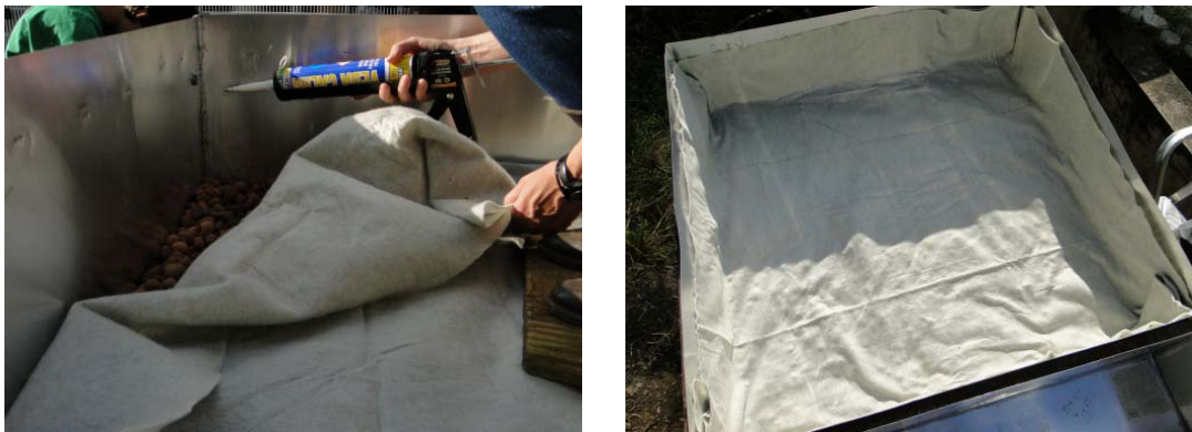
Figura 30: Aplicação do tecido geotêxtil. Fonte: A autora (2011).
