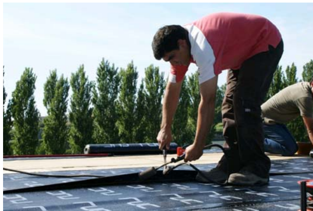
Figura 8: Execução da impermeabilização. Fonte: cantinhodasaromaticas (2011).
