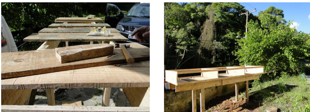
Figura 23: Estrutura em madeira em fase de montagem e pronta. Fonte: A autora (2011).
