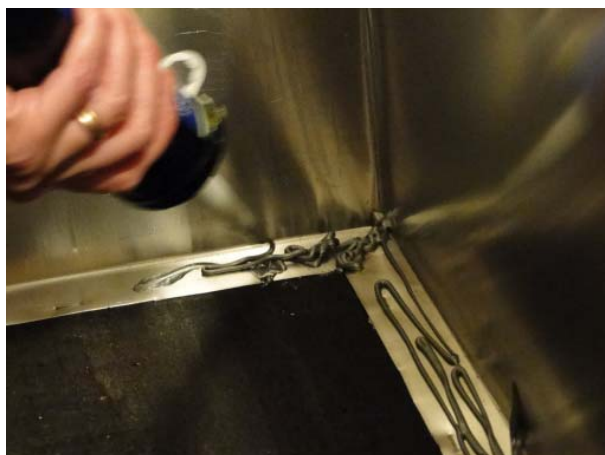
Figura 25: Aplicação de vedante para calhas. Fonte: A autora (2011).
