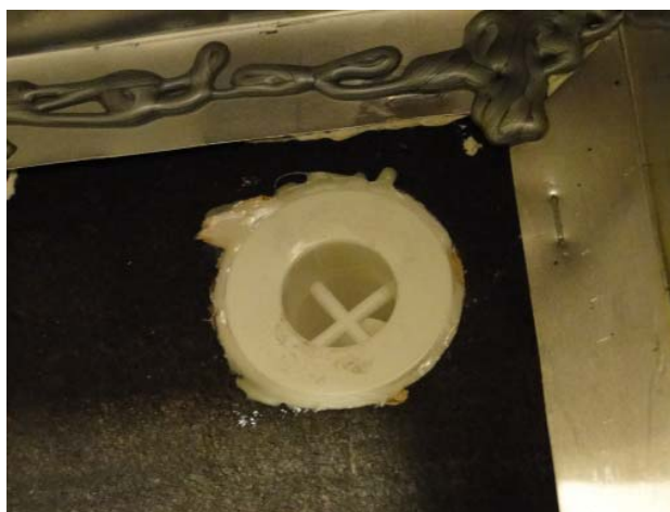
Figura 26: Detalhe da válvula de escoamento. Fonte: A autora (2011).
