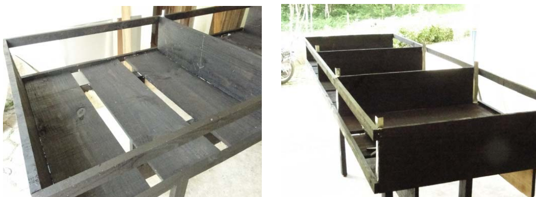
Figura 24: Estrutura em madeira protegida com emulsão asfáltica. Fonte: A autora (2011).
