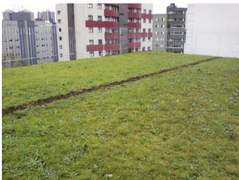
Figura 17: Telhado verde no bairro de Vila Isabel em Curitiba. Fonte: A autora (2011).
