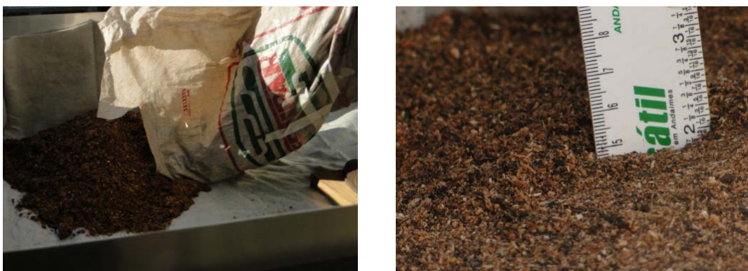
Figura 31: Colocação do substrato. Fonte: A autora (2011).
