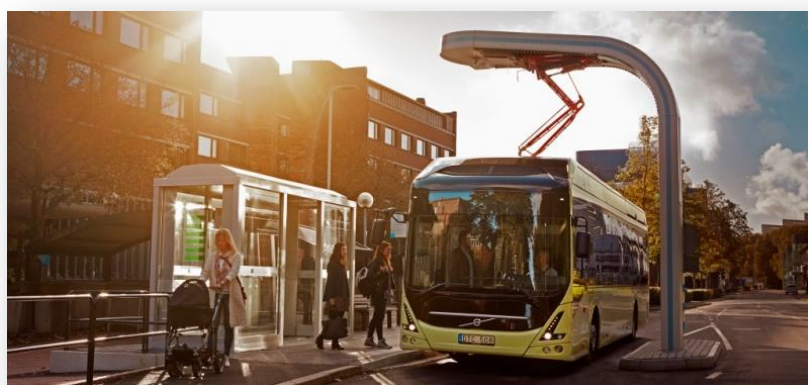
FIGURA 4 – ESTAÇÃO DE CARREGAMENTO – TIPO PANTOGRÁFICA
