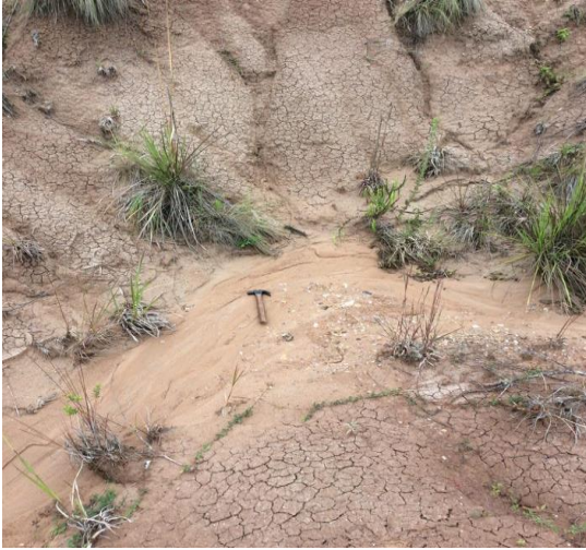
FOTO 5 – EROSÃO Fonte: O autor (2015).
