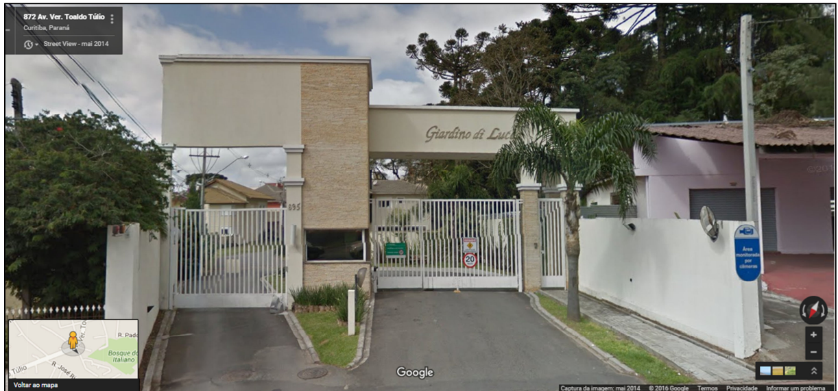
FIGURA 5 – FACHADA DE CONDOMÍNIO HORIZONTAL DE ALTO PADRÃO NA RUA AV. TOALDO TÚLIO, 895
