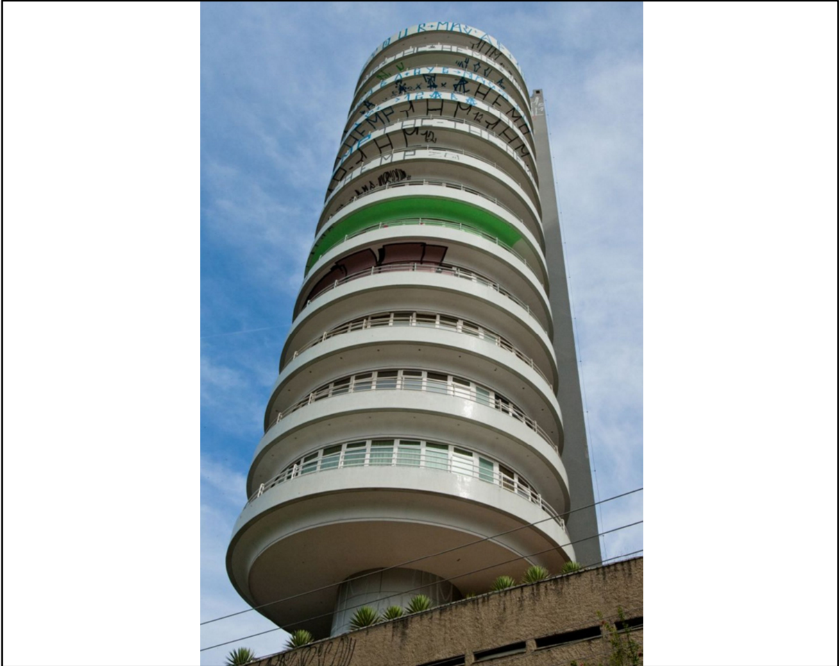
FIGURA 1 - FACHADA DO SUITE VOLLARD: DEPOIS DA PICHAÇÃO FONTE: GAZETA DO POVO (2012)
