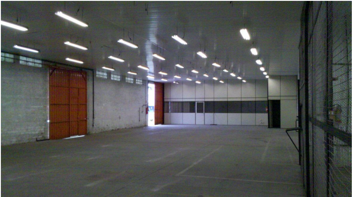
FIGURA 6 – ÁREA PARA INSTALAÇÃO DO SETOR TÉCNICO DE MANUTENÇÃO MECÂNICA
