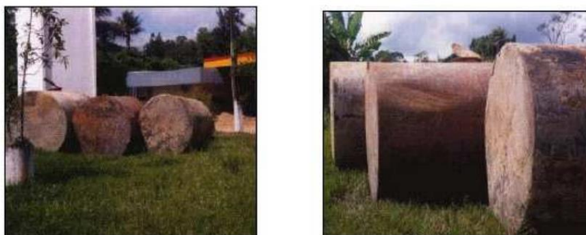
Figura 3: Tanques de armazenamento de combustíveis corroídos. Fonte: JUNIOR e PASQUALETO (2008)
