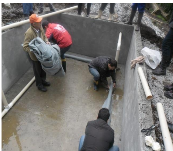
Figura 04 A. Colocação da Manta.
