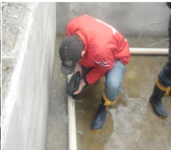
Figura 03 B. Perfuração para distribuição.
