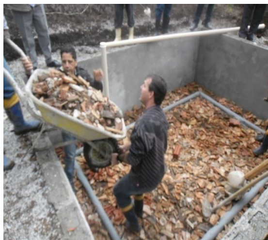
Figura 04 B. Preenchimento com telhas.
