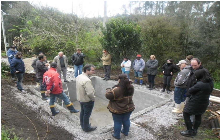
Figura. 02. Tanque de raízes, pronto para receber os materiais filtrantes. Fonte: Autora (2013).
