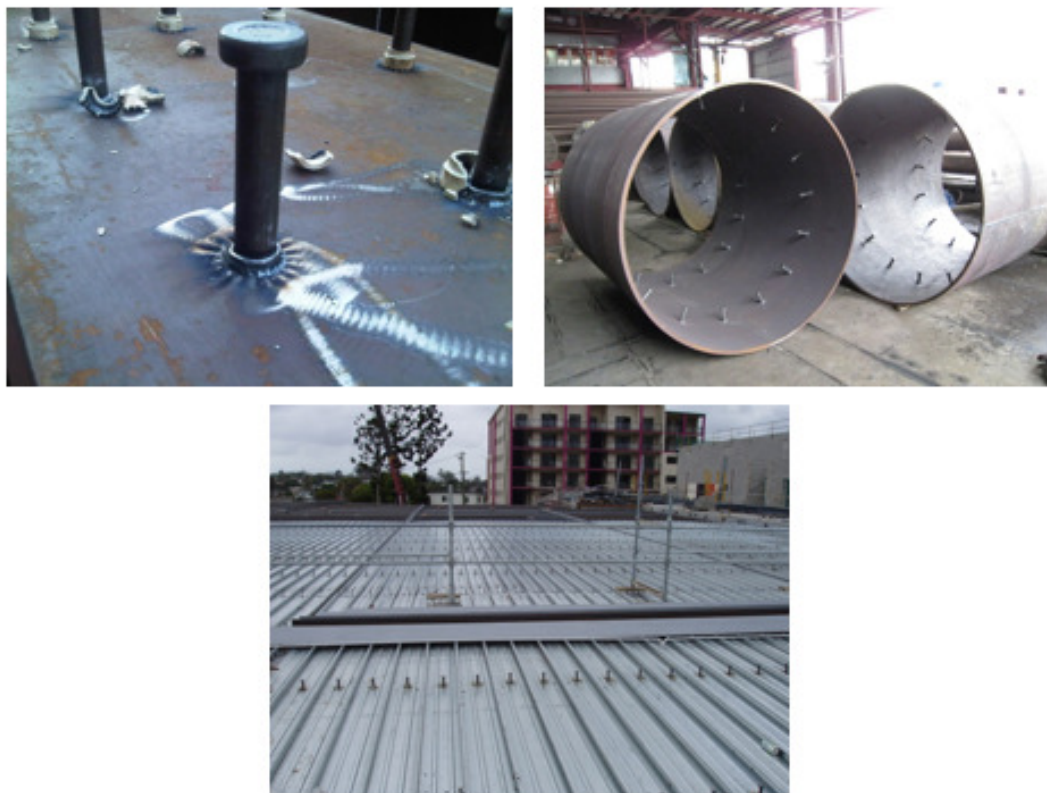
Figura 1. Algumas aplicações da soldagem de pinos (pesquisa google imagens stud weld, 8 de julho de 2013)
