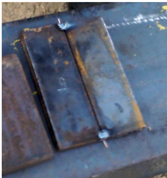
Figura 3.1 – Junta preparada para receber solda.
