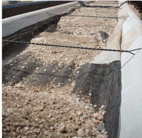
Figura 4. Canaleta de fibro-cimento para instalação de jardim clonal
