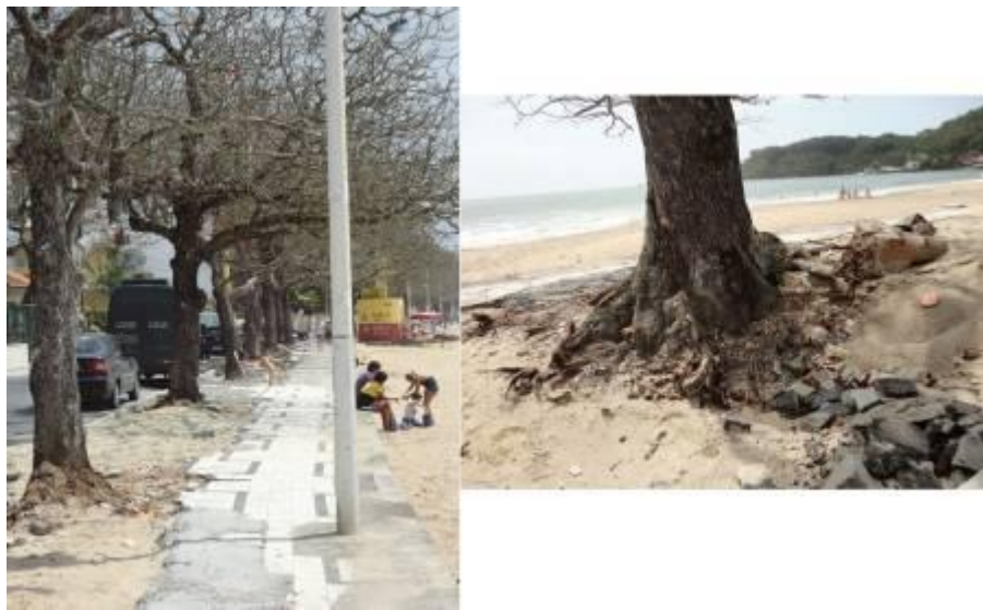
Figura 10: Obras de reparo do calçamento danificado pelo sistema radicular das árvores (Cabeçudas).
