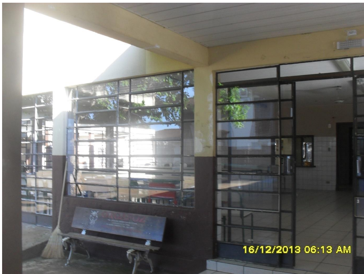
Foto 3: Entrada do refeitório do colégio
