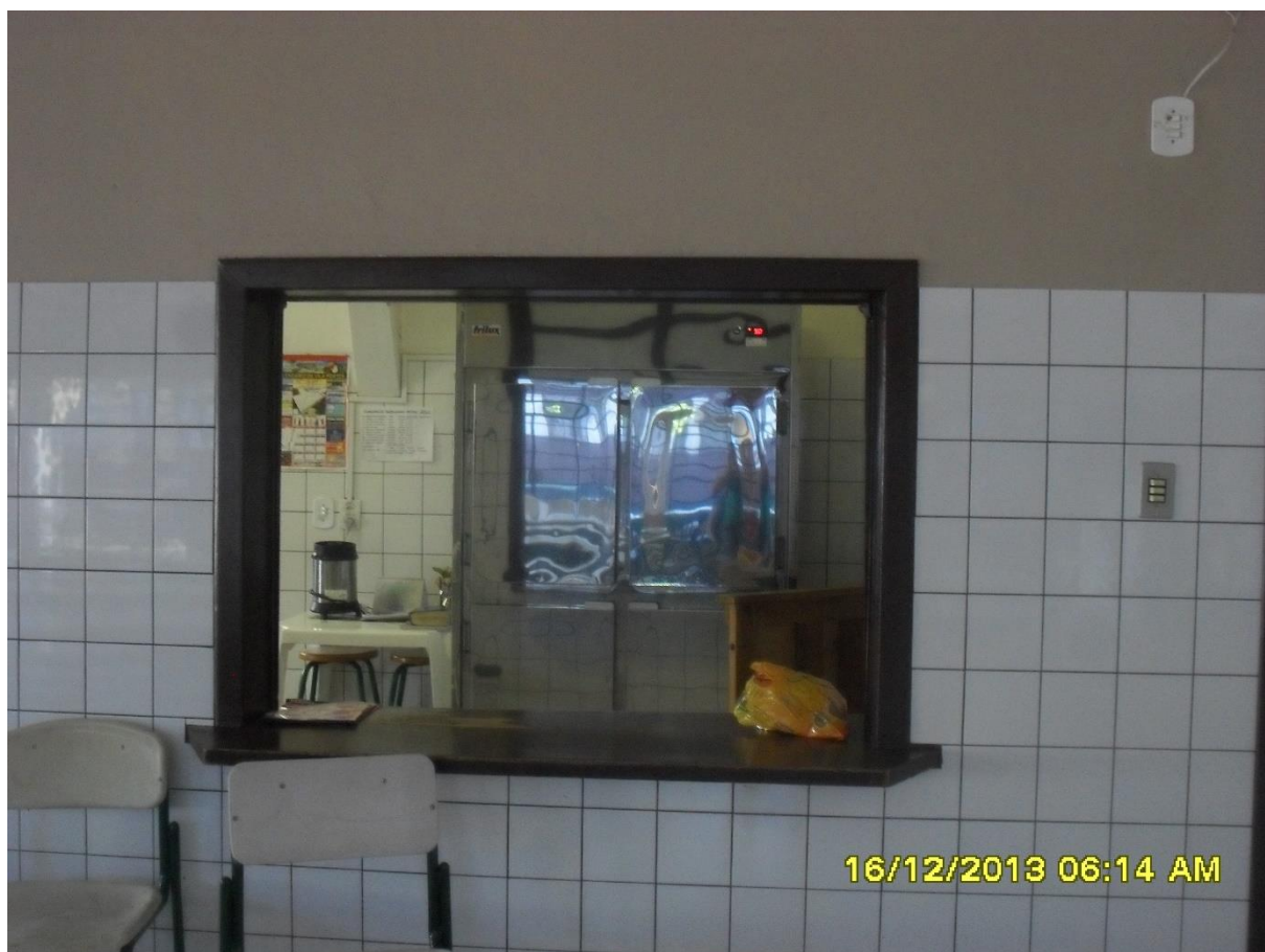
Foto 1 – Parede na qual é anexado o cartaz com o cardápio diário.
