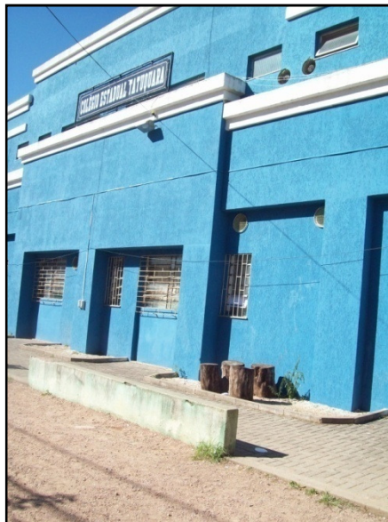
FIGURA 1: Fachada da escola
