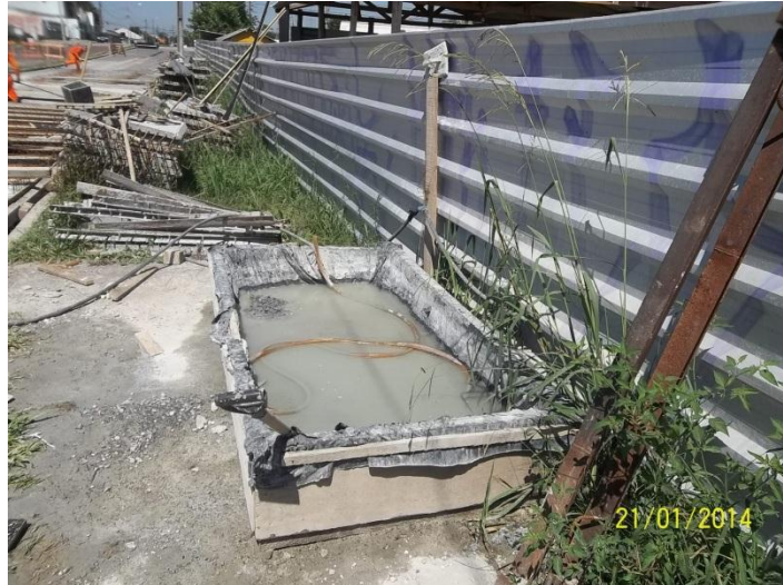
FIGURA 2 – Caixa de sedimentação de resíduos de concreto para limpeza de ferramentas
