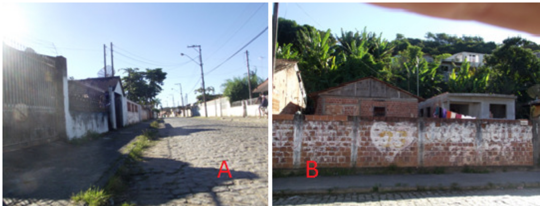
Figura 05: Condições das Calçadas no bairro do Portinho, Antonina, 2013. Fonte: Mauricio Frank.
