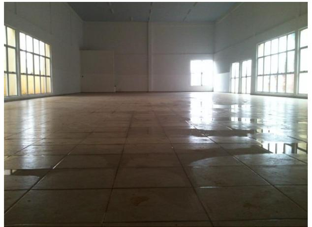
**Figura 06: Falta da especificação do caimento do piso em memorial descritivo.**
