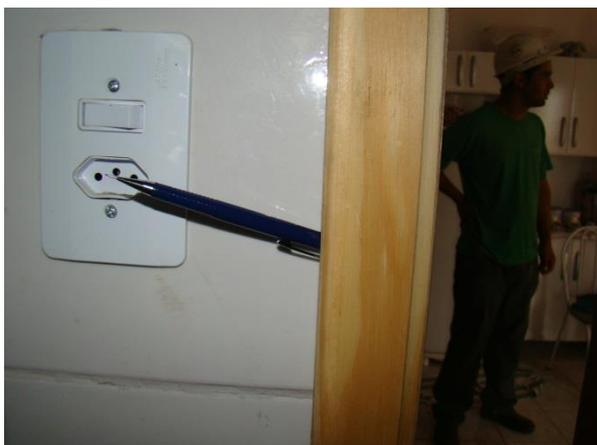
**Figura 01:** Vãos entre batente da porta e parede reflexo da madeira de baixa qualidade em habitação popular.
