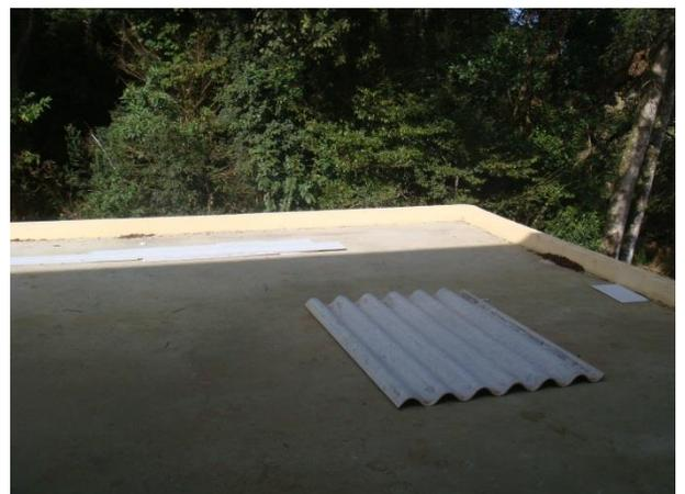
**Figura 08: Falta de detalhes da cobertura acarretou na falta de rufos e calhas.**
