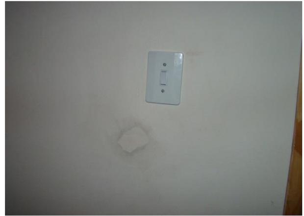
**Figura 04: Aplicação de Tinta inadequada para a parede em habitação popular.**
