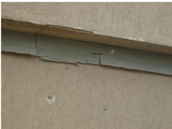
**Figura 07: Descolamento do grafiato da parede em wood frame.**
