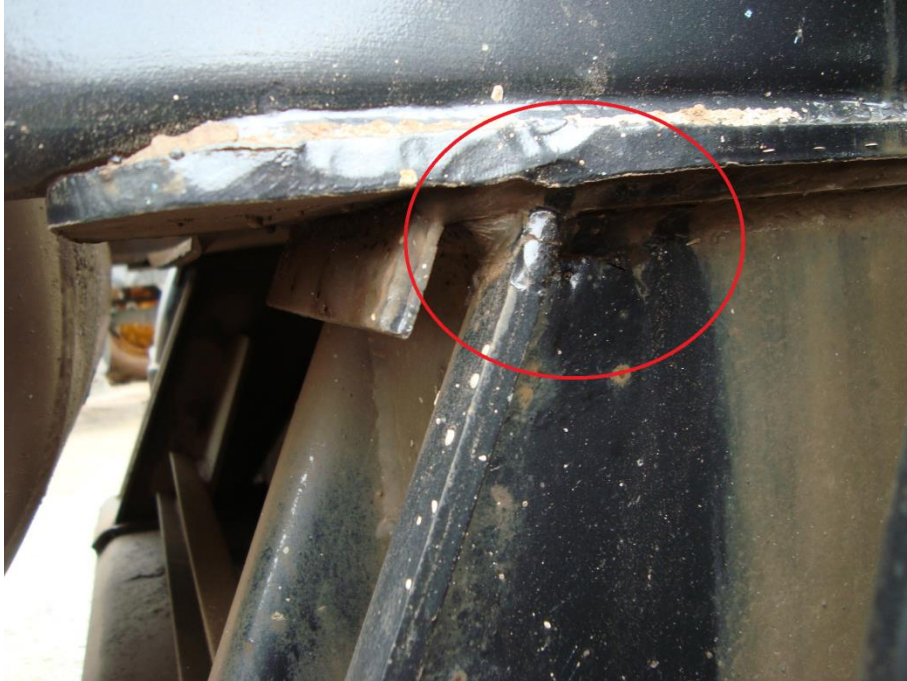
Figura 8 – Trincas típicas no suporte dianteiro – canto superior do suporte da suspensão.
