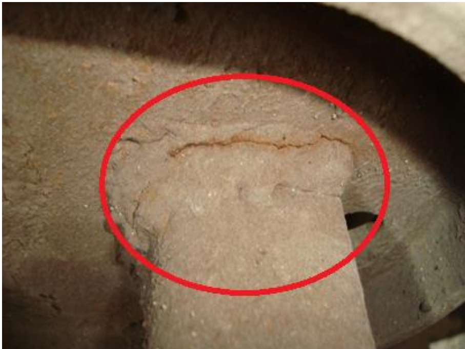
Figura 3 – Trincas típicas no suporte traseiro – travessa.
