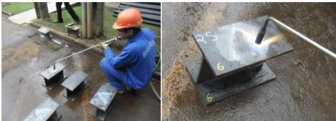
Figura 21 - Aquecimento em V com maçarico
