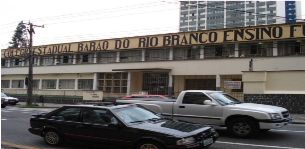
FOTO 1 – FACHADA DO COLÉGIO ESTADUAL BARÃO DO RIO BRANCO
