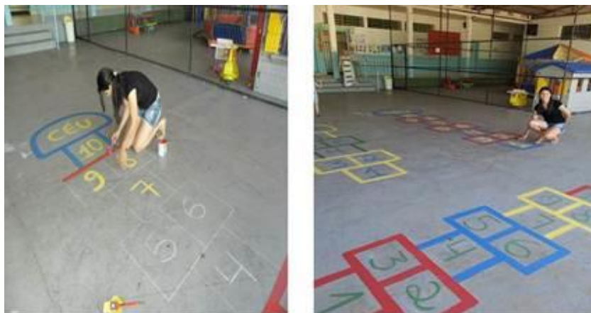
FIGURA 4 – CONSTRUÇÃO DAS AMARELINHAS. Fonte: A autora (2013)
