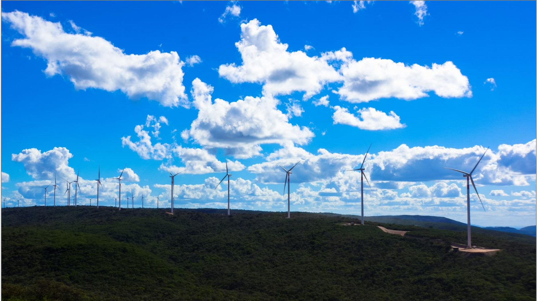
FIGURA 9 – SUB PARQUE EÓLICO. FONTE: O AUTOR (2014)
