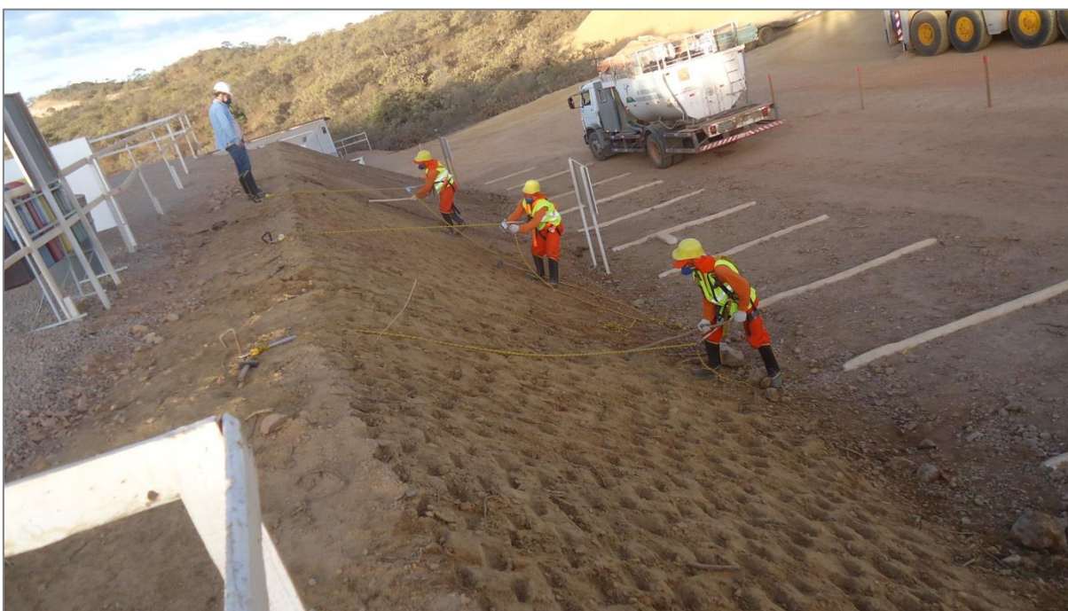
FIGURA 17 – APLICAÇÃO DE HIDROSSEMEADURA (PBA Nº P02) FONTE: O AUTOR (2013).
