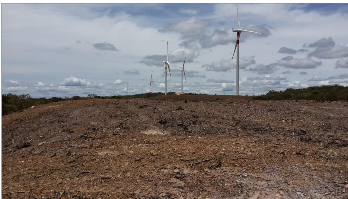
FIGURA 29 – COBERTURA DE ÁREA DEGRADADA COM SOLO ORGÂNICO (PBA Nº P14) FONTE: O AUTOR (2014).
