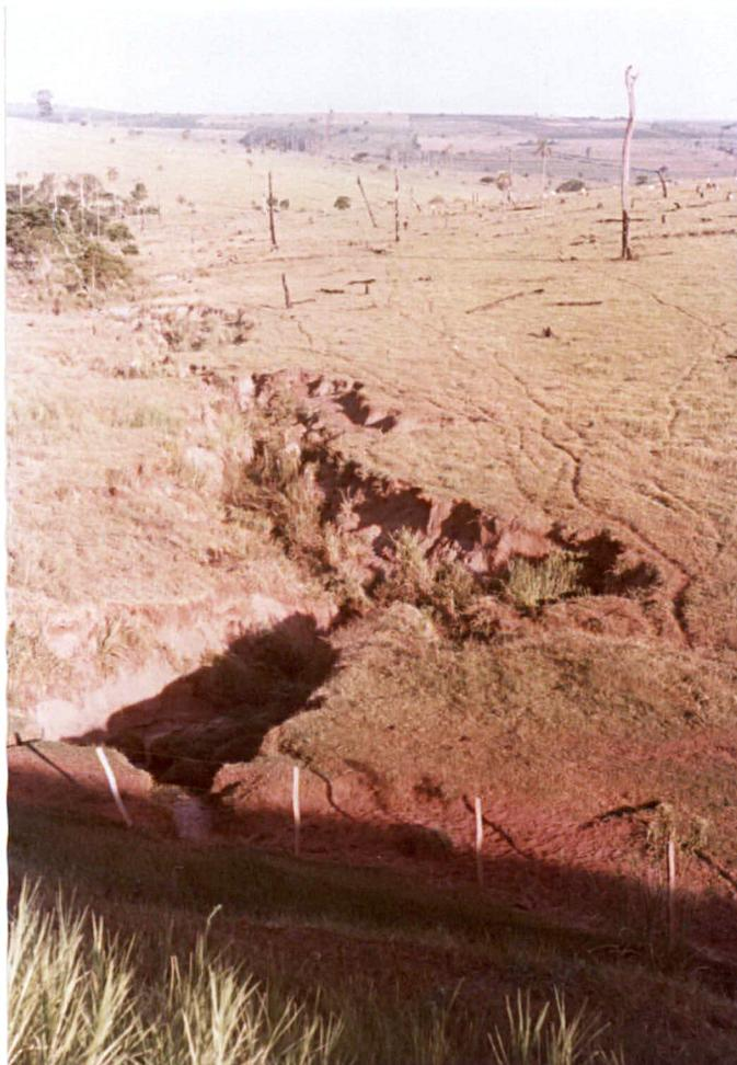
Foto nº 10 - Estrada de ligação entre Rondon-Paraíso do Norte. Vê-se, em primeiro plano, um sulco profundo, provocado pela construção da rodovia. Nota-se junto à cerca o solo desnudo, além de múltiplos caminhos provocados pelo pisoteio do gado, contribuindo para a formação de novos sulcos de erosão.
