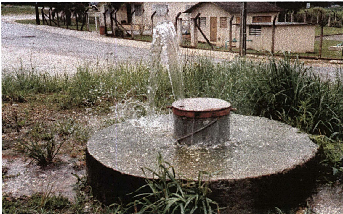
FIGURA 23 - POÇO SURGENTE (P-14), NA BACIA DO RIO TUMIRI, PRÓXIMO À ESTAÇÃO DE TRATAMENTO DE ÁGUA – SANEPAR
