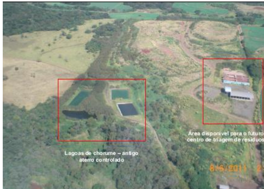
FIGURA 7 – FOTO AÉREA DA ÁREA ONDE LOCALIZA-SE O ANTIGO ATERRO E A ÁREA DISPONÍVEL PARA O FUTURO CENTRO DE TRIAGEM.
