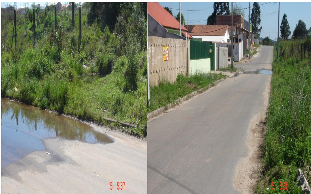
Figura 13 – FLUXO NASCENTE SOBRE O ASFALTO NO BAIRRO PARQUE DOS LAGOS. FOTO OBTIDA PELO AUTOR (2013).
