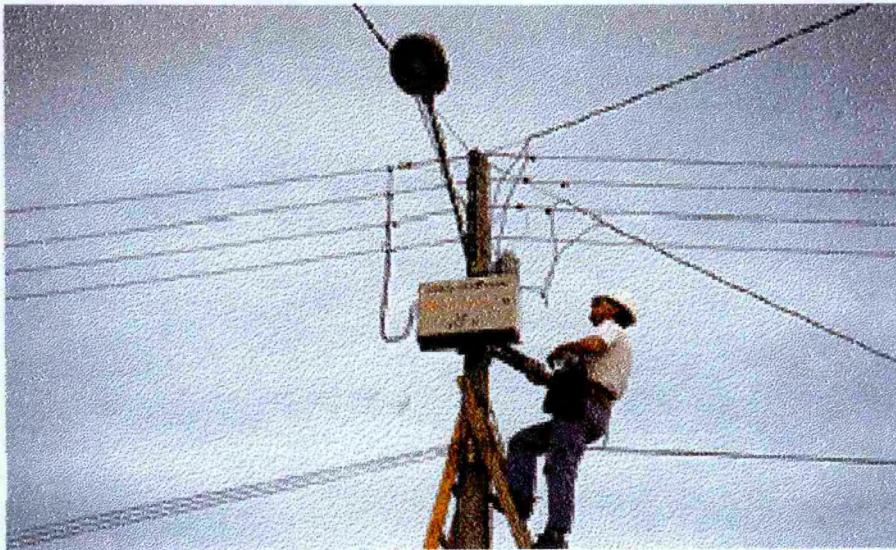
FIGURA 2 – FUNCIONÁRIO DA COPEL EFETUANDO LIGAÇÃO
