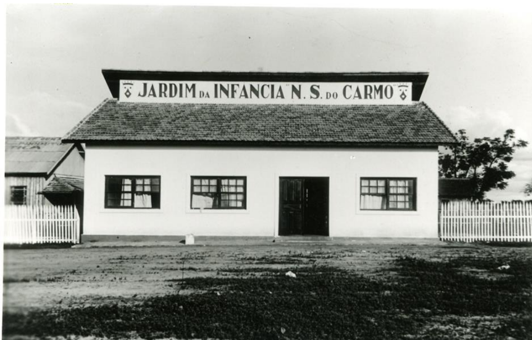
FIGURA 19 - PRÉDIO DO JARDIM DE INFÂNCIA NOSSA SENHORA DO CARMO
