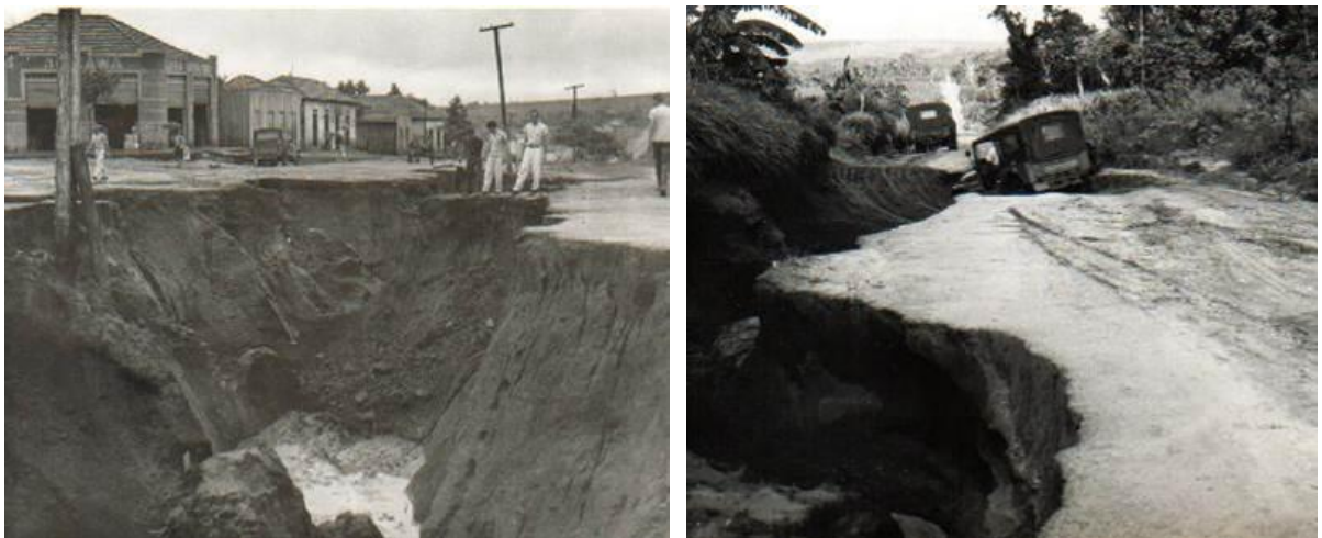
FIGURA 12 - EROSÕES DA DÉCADA DE 1960 NA CIDADE DE COLORADO - PR
