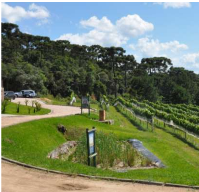
FOTO 18: TANQUE AMBIENTAL – VINÍCOLA ARAUCÁRIA FONTE: Acervo da autora (2017).
